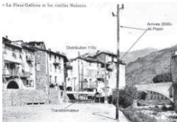
Place Gallone, la ligne 5000v, le transformateur, la distribution 110v
