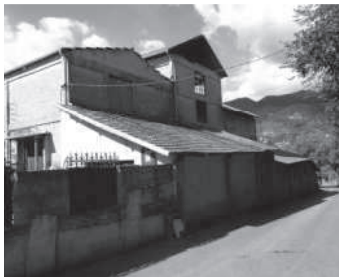
Usine de la plâtrière du Roccas aujourd'hui
